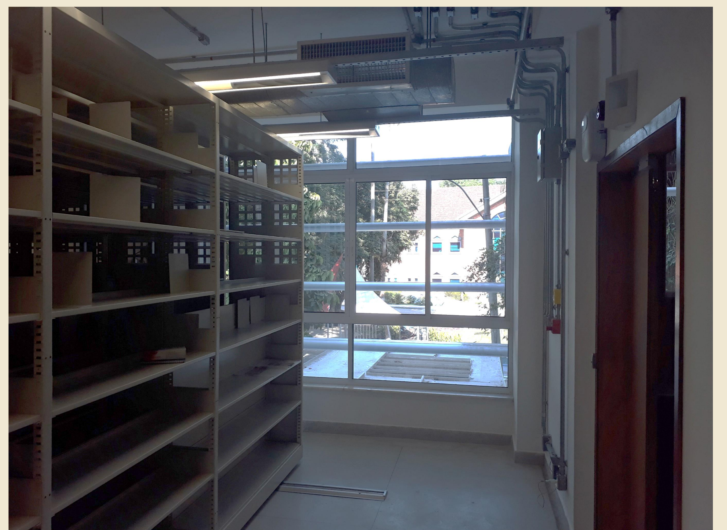
Acervo corrente antes da proteção na janela. Foto: As autoras.
