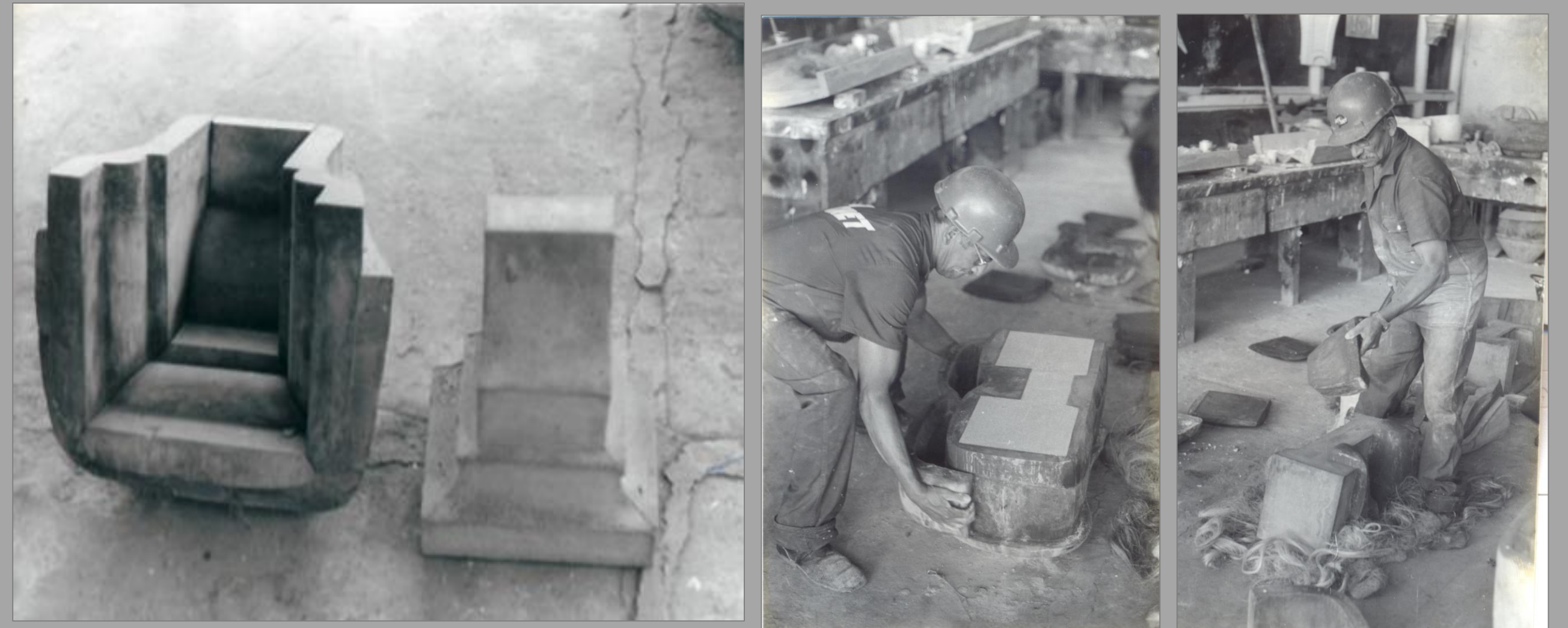
Forma e réplica em argamassa cimentícia. Elemento ornamental da Torre Norte(1989) e Mestre Adorcino executando peças. Fonte: DPH/COC/Fiocruz
