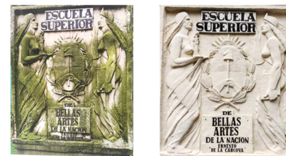
Fig. 5 Vista del antes y después de la intervención de restauración del “Escudo de la Escuela Superior de Bellas Artes”, relieve de piedra reconstituida y cobre. Circa 1934-1935 . Fuente: Vilma Pérez-Casalet, 2022.
