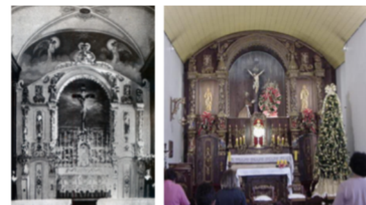
Fig.2 Capela-mor antes (esq.) e depois (dir.) das intervenções de 1978. Fonte: Casa da Memória e acervo das autoras.
