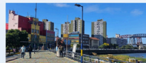
Vista general de la escuela ubicada al lado del Río Matanza Riachuelo
